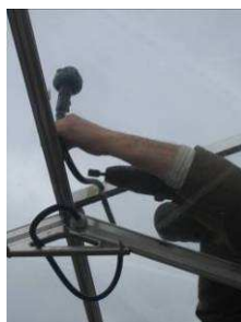
Figuur 2 Monteer de deksproeier van binnenuit door het luchtraamprofiel
