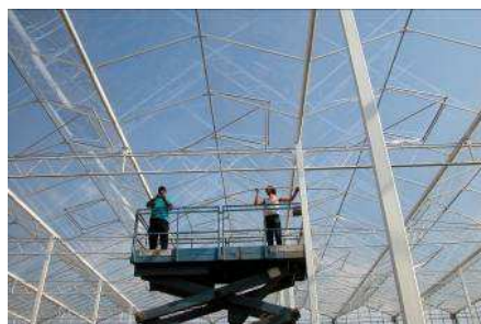
Figuur 1 Goed! Werk van binnenuit met een hoogwerker voordat de schermdoekinstallatie is aangebracht
